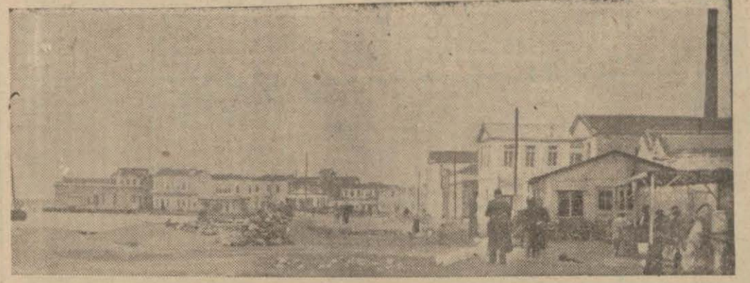
Ayvalık rıhtımında kaldırım yapılırken
